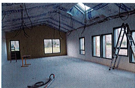
Travaux dans les salles de classe.
